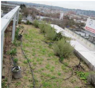
Fig. 3.2.8: A. Green roof beds
